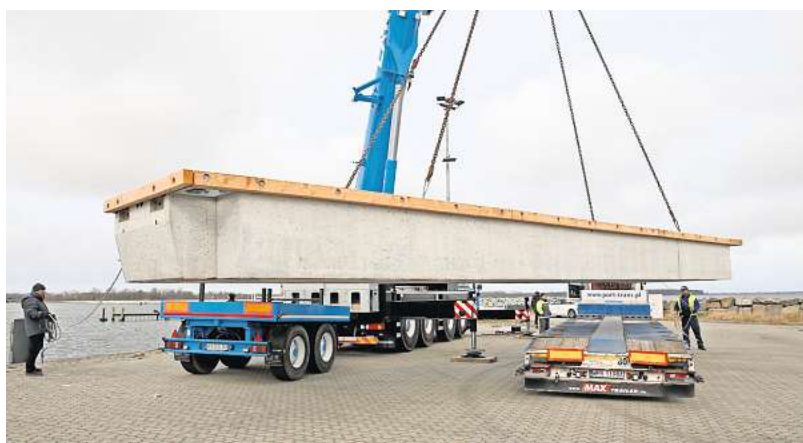
Die drei je 24 Tonnen schwere Segmente der Steganlage, antransportiert mit polnischen Schwerlast-Lkw, werden im Wirtschaftshafen abgeladen.
